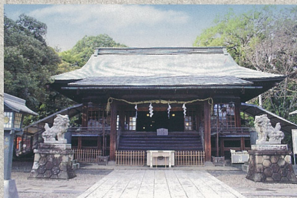
▲拝殿（栃木県指定文化財）修理工事
