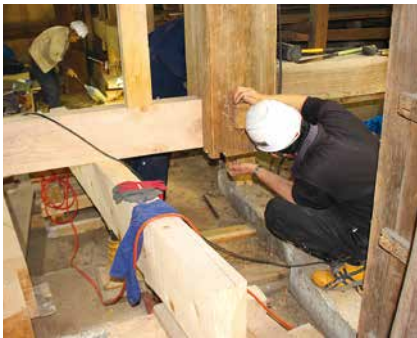
慎重に、ていねいに、土台や梁、柱などを修理していきました。
