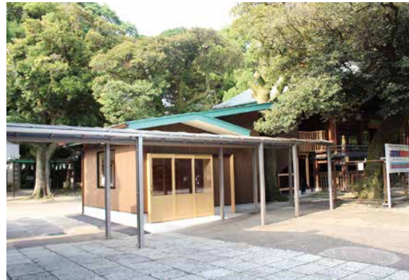
◆ 拜殿昇殿口改築
