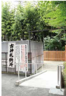
◆ スロープ設置 (社務所北東側、焚き上げ所)
