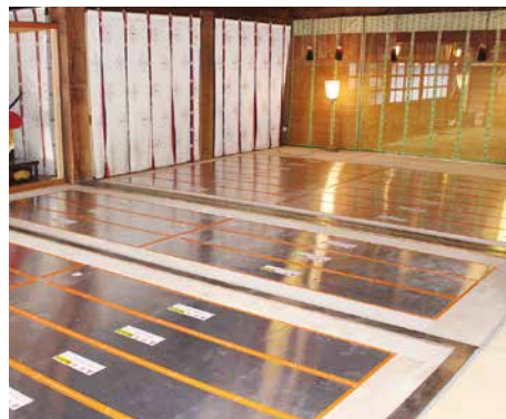
◆ 拜殿床暖房設置
